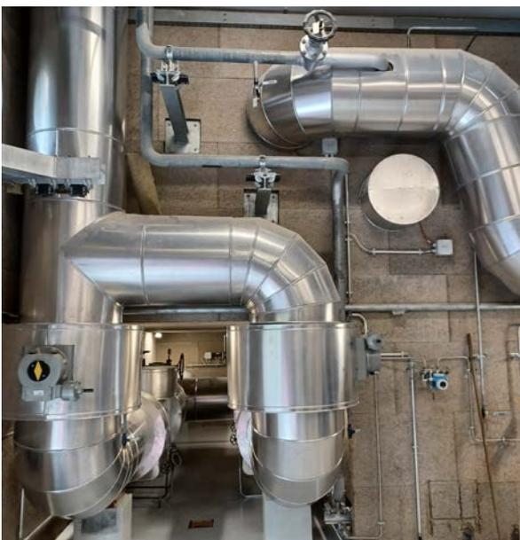
Arrivée et sortie de l'eau chaude dans le réseau de chauffage à distance
